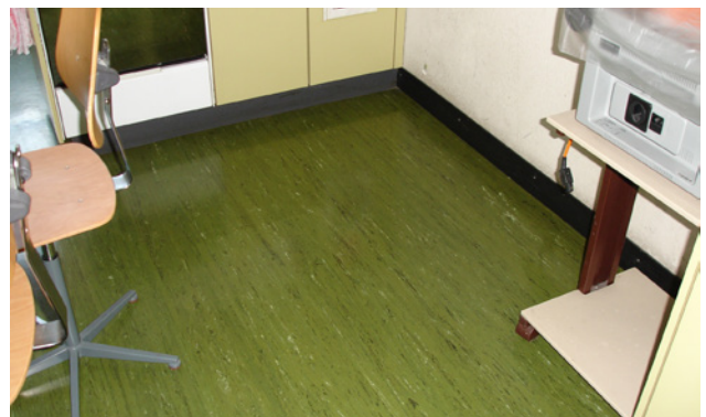
2 Auch bei diesen elastischen Bodenbelagsbahnen ist der Asbest im Kunststoff festgebunden.
