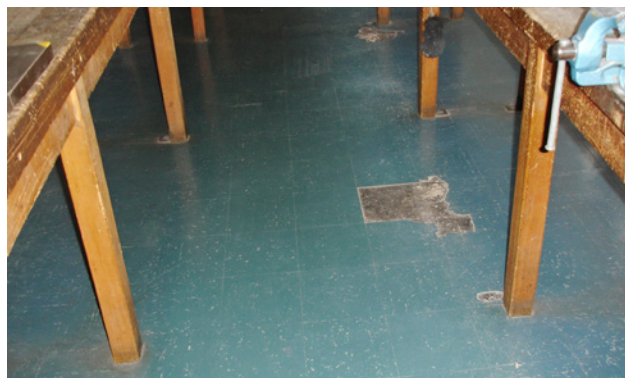
1 Einschichtige sogenannte Floor-Flex-Beläge. Hier ist der Asbest in der Matrix festgebunden.
